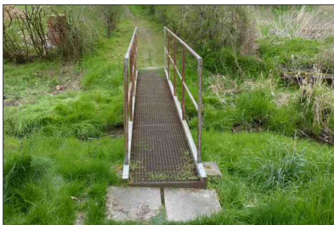
Lávka 1d-L1 - staničení 0,062 - celkový pohled
