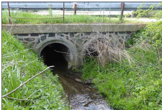
Propustek 1c - staničení 0,787 - pohled zprava
