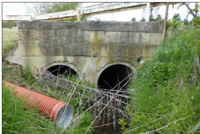
Propustek 1c - staničení 0,787 - pohled zleva
